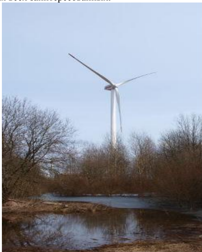
Рисунок 1 – Ветряная электростанция (ВЭС) в Грабниках
