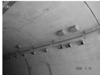
Рисунок 6 – Продольные трещины
