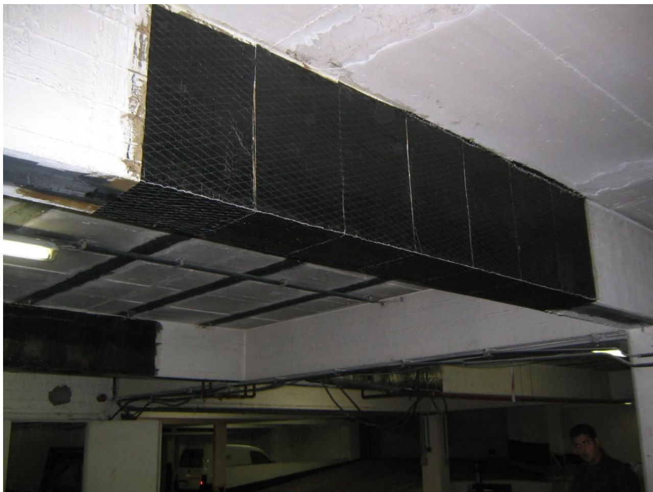
Рисунок 2 – Усиление конструкции углеволокном
