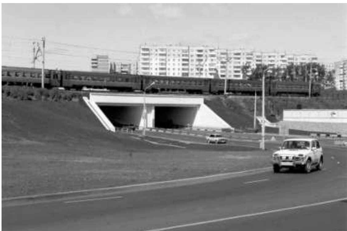
Рисунок 3 – Тоннель под железной дорогой в створе улицы Васильева в г. Перми
