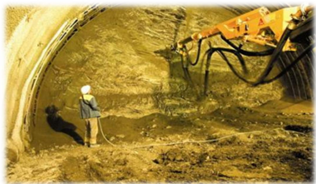
Рисунок 7 – самоходная машина для нанесения набрызг-бетона
