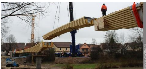
Рисунок 2 – Сборка моста
