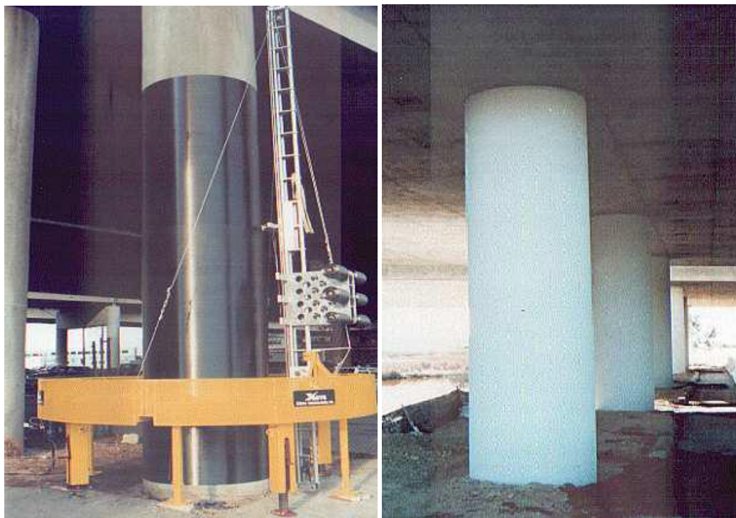
Рисунок 1 – Применение углепластика в виде холста для усиления опор [2]
