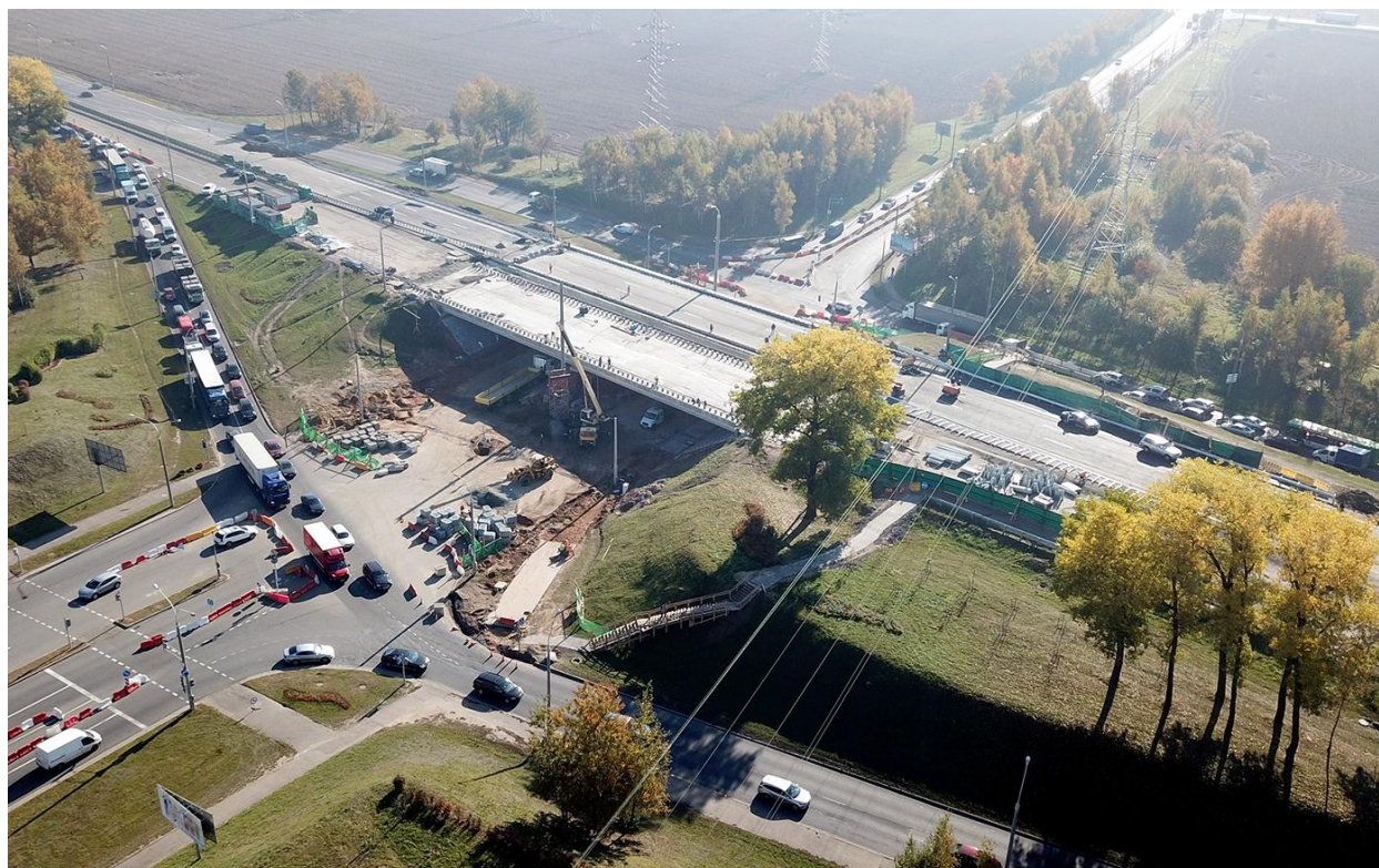
Рисунок 2 – Работы на путепроводе в стадии завершения
