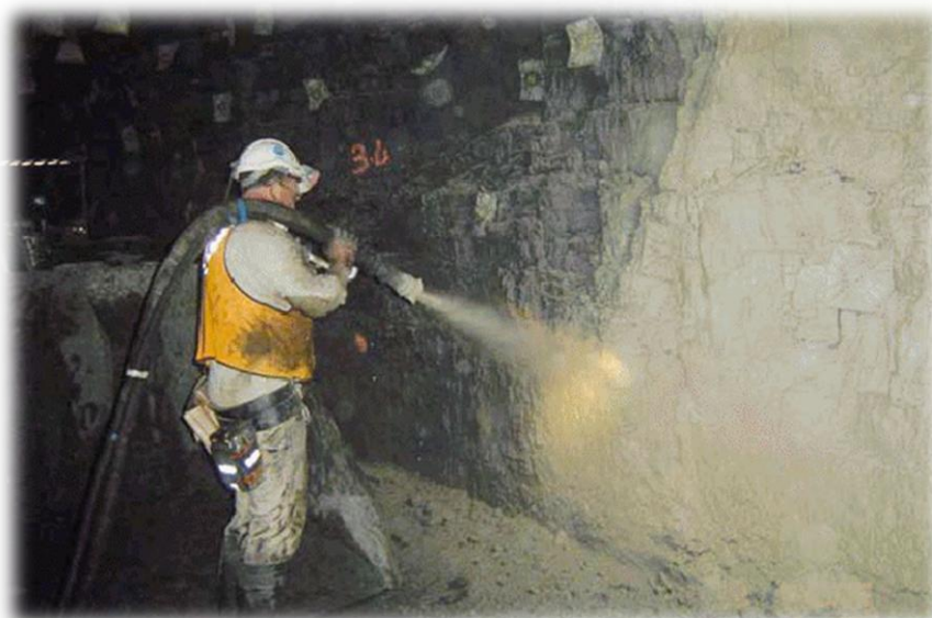
Рисунок 4 – нанесение набрызг-бетона
