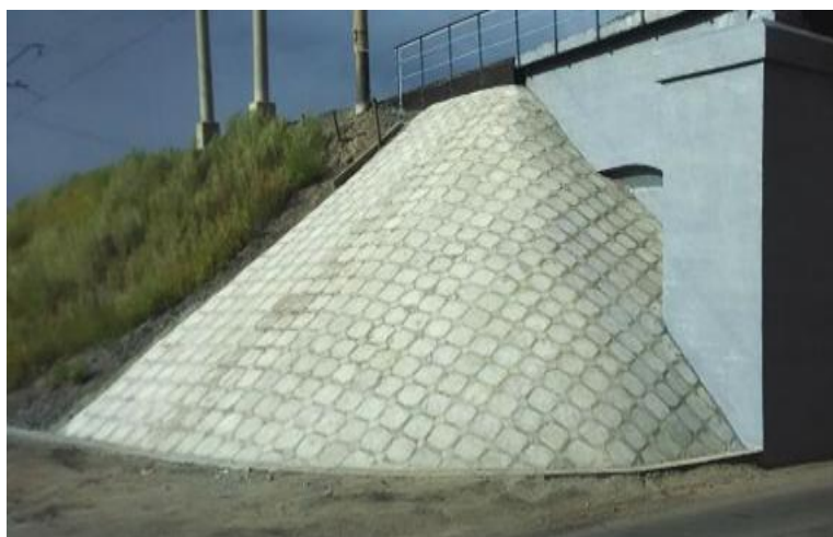
Рисунок 2 – Укрепление конуса насыпи бетонными плитами
