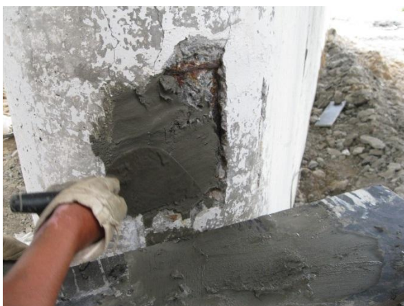
Рисунок 5 – Нанесение ремонтных бетонов методом торкретирования
