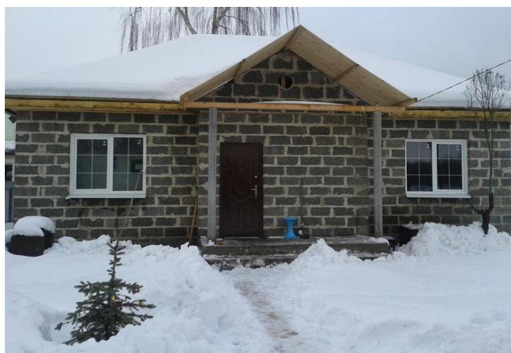
Рисунок 2 – Сооружение из опилочного бетона
