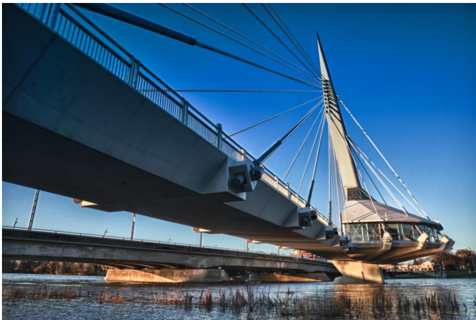
Рисунок 3 – Пешеходный мост Esplanade Riel Pedestrian Bridge. Вид снизу. Источник: https://en.wikipedia.org/wiki/Esplanade_Riel
