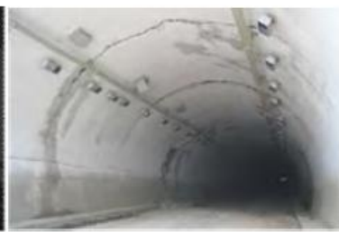
Рисунок 7 – Поперечные трещины
