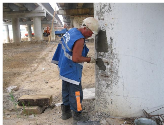
Рисунок 5 – Нанесение ремонтных бетонов методом торкретирования
