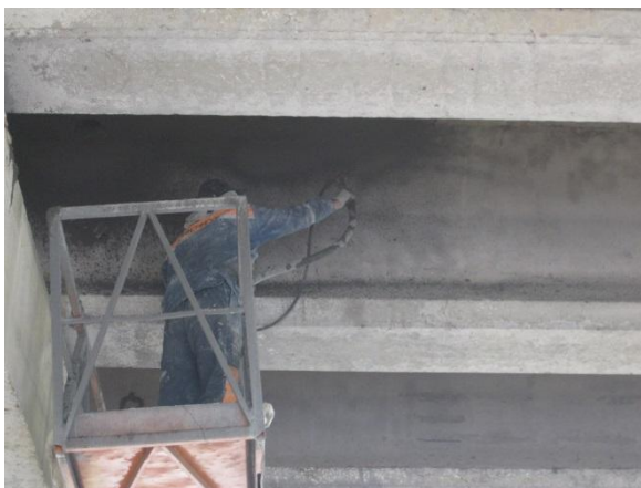
Рисунок 4 – Нанесение ремонтных бетонов методом торкретирования
