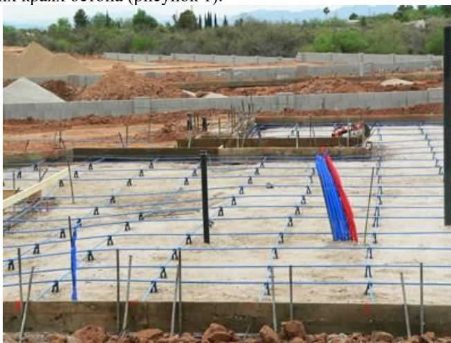
Рисунок 1. Применение технологии пост-напряжения [3]
