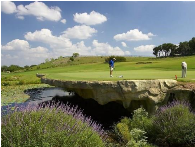
Рисунок 2. Поле для гольфа зеленого цвета – фактически пост-напряженная железобетонная консольная плита производства фирмы Suncoast Post-Tension, США
