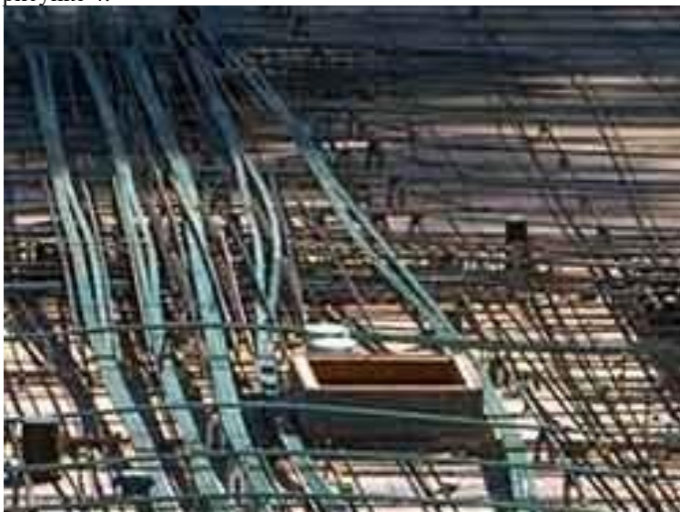
Рисунок 4. Расположение пост-напряженных канатов при устройстве отверстий [3]
