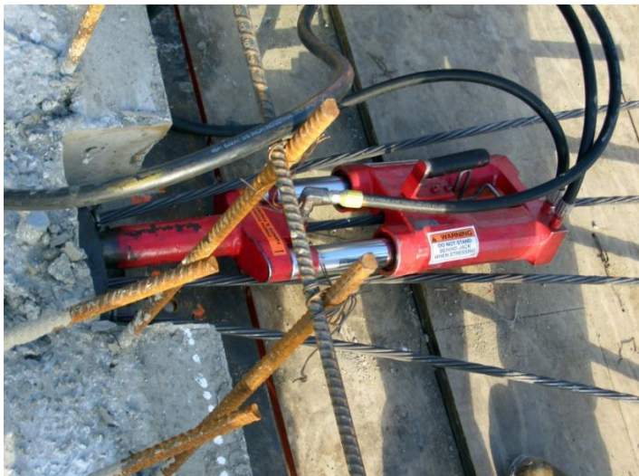
Рисунок 5. Домкрат для натяжения каната
