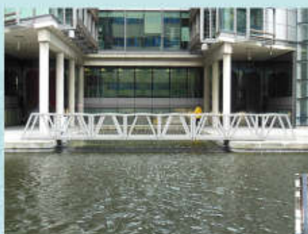
Сворачивающийся мост (пешеходный) Откатная система, г. Лондон Общая длина разводного пролета: 12 м.
