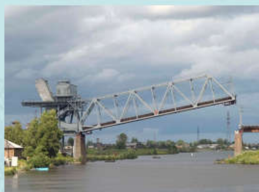
Шженский железнодорожный мост Откатно-раскрывающаяся система, г. Беломорск (2 в мире) Общая длина разводного пролета: 66 м.
