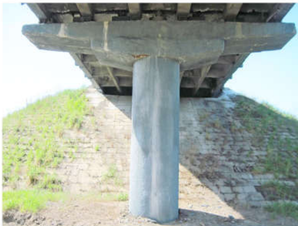
Опора путепровода на автодороге М10 у г.Калинковичи
