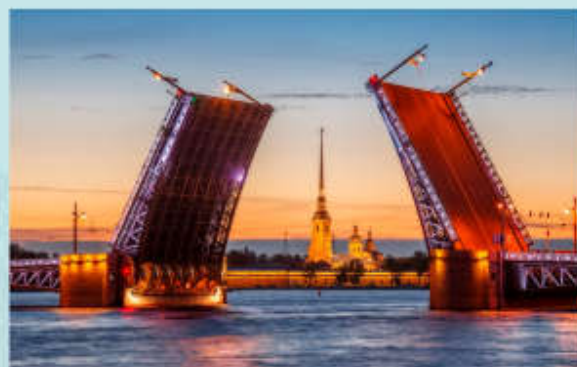
Раскрывающаяся система Дворцовый мост, Санкт-Петербург Общая длина разводного пролета (двукрылый): 56,6 м
