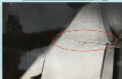
Трещины в сварных швах прикрепления радиальных ребер жесткости к втулке оси вращения (Троицкий разводной мост)
