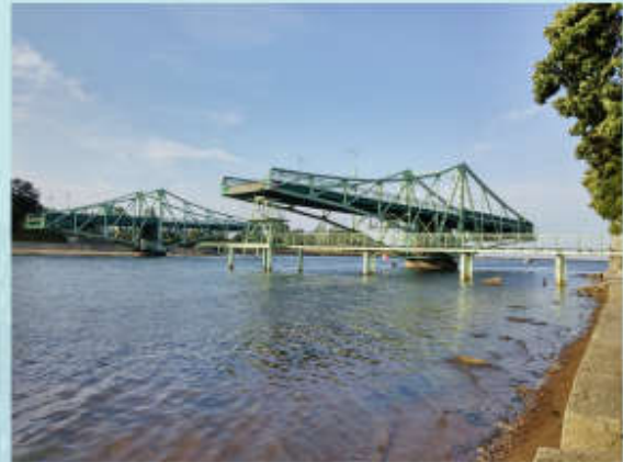
Мост Оскара Каллака, Поворотная система, г. Лиепая (Латвия) Общая длина разводного пролета: 132,28 м Длина центрального пролета: 64 м
