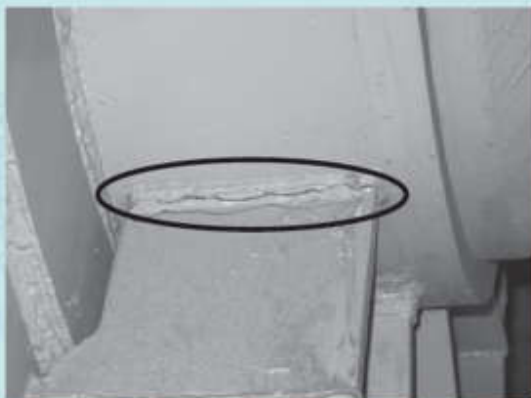
Трещины в сварных швах прикрепления радиальных ребер жесткости к втулке оси вращения (Володарский разводной мост)
