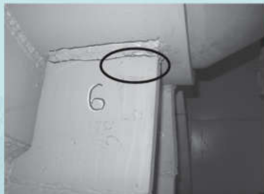
Трещины в сварных швах прикрепления радиальных ребер жесткости к втулке оси вращения (Володарский разводной мост)
