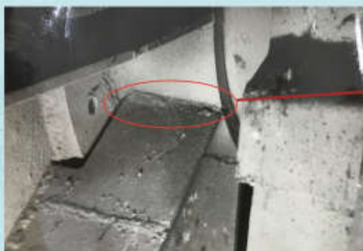
Трещины в сварных швах прикрепления радиальных ребер жесткости к втулке оси вращения (Троицкий разводной мост)
