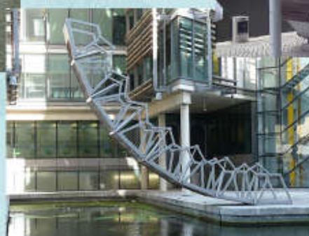
Сворачивающийся мост (пешеходный) Откатная система, г. Лондон Общая длина разводного пролета: 12 м.
