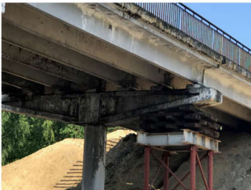
Опора путепровода на автодороге М10 у г.Лунинец
