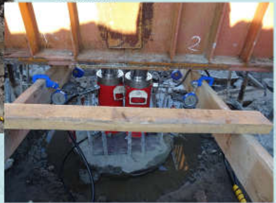
Расположение приборов для измерения перемещения сваи. Опора №32
