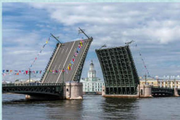
Раскрывающаяся система Дворцовый мост, Санкт-Петербург Общая длина разводного пролета (двукрылый): 56,6 м
