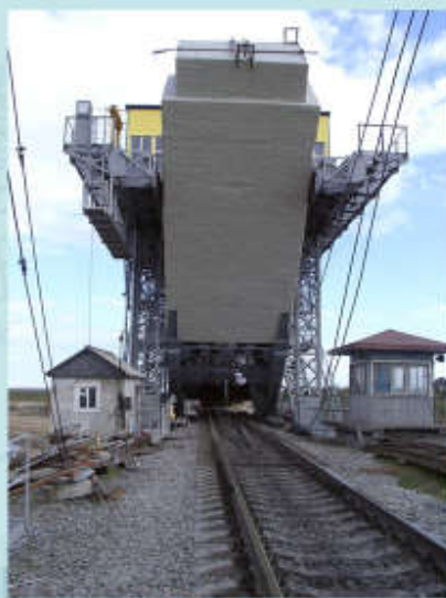
Шженский железнодорожный мост Откатно-раскрывающаяся система, г. Беломорск (2 в мире) Общая длина разводного пролета: 66 м.
