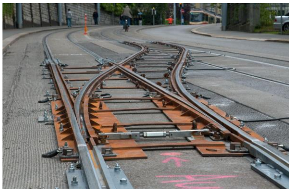
Рисунок 12 – Внешний вид накладного стрелочного перевода
