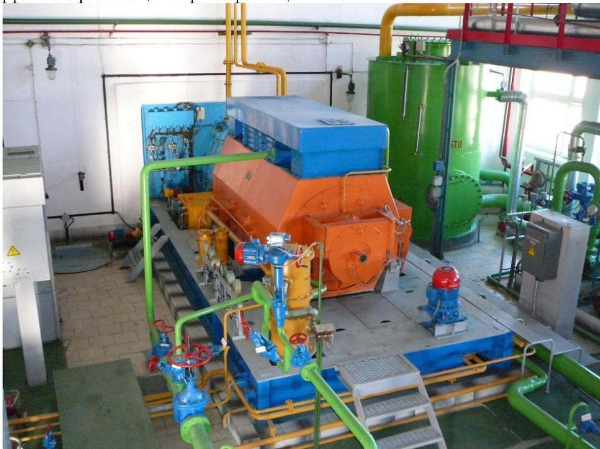
Рисунок 2 – Общий вид на детандер-генераторную, установку 5000 кВт (ДГУЭ-5000)
