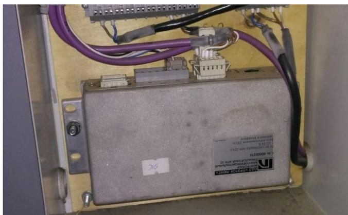
Рисунок 5 - Контроллер многофункциональный МТК-12
