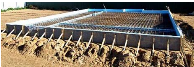
Рис. 2.5. Подготовленная к укладке бетонной смеси опалубка со смонтированными арматурными каркасами
