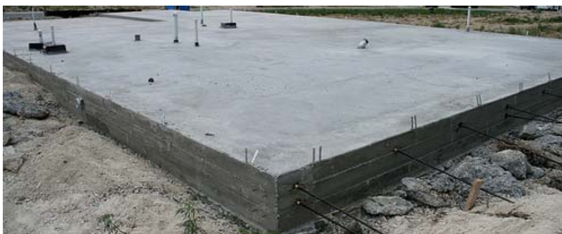
Рис. 2.8. Монолитная фундаментная плита
