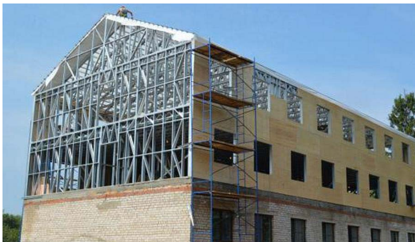
Рис. 8.24. Реконструкция (надстройка этажей) здания с применением ЛСТК
