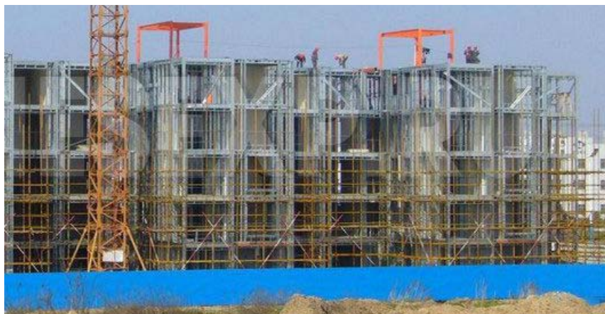
Рис. 8.16. Несущий каркас жилого здания из ЛСТК
