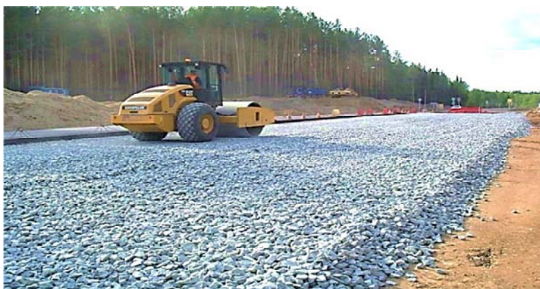
Рис. 6.3. Схема устройства основания из щебня: a – доставка щебня; б – разравнивание, планировка и уплотнение щебня
