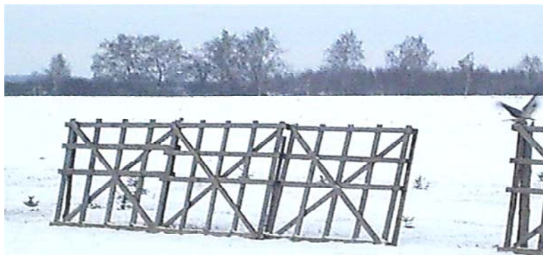
Рис. 8.15. Установка решетчатых щитов с разрывом
