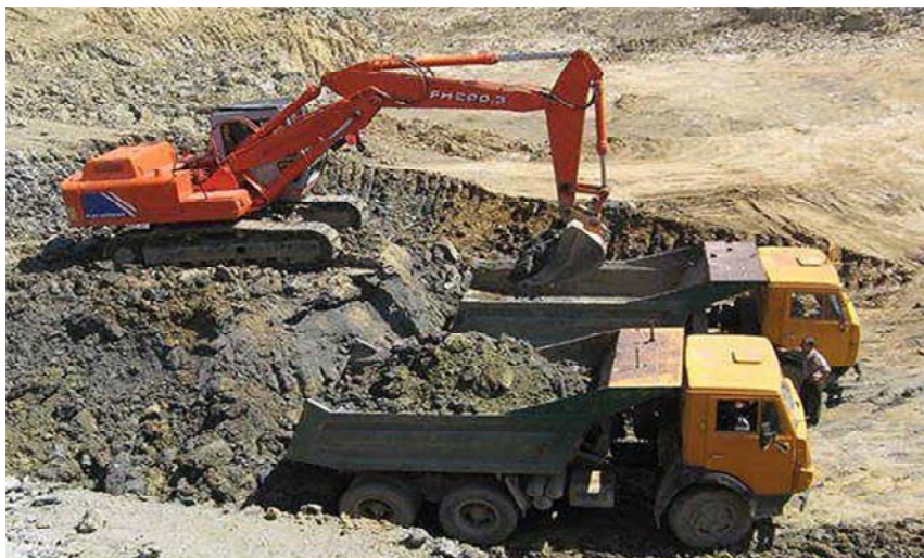
Рис. 5.19. Работа экскаватора на гусеничном ходу
