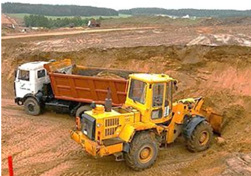
Рис. 5.17. Разработка выемки фронтальным погрузчиком
