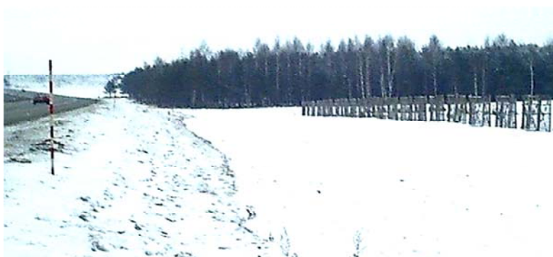
Рис. 8.13. Установка решетчатых щитов
