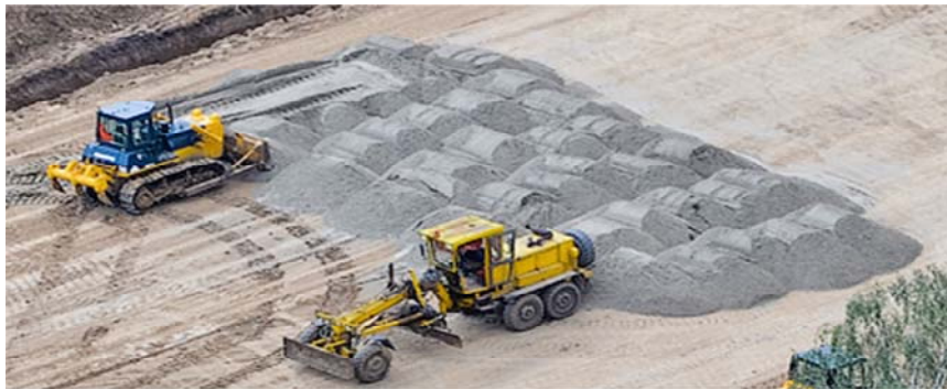
Рис. 6.2. Схема отсыпки дренирующего слоя дорожной одежды
