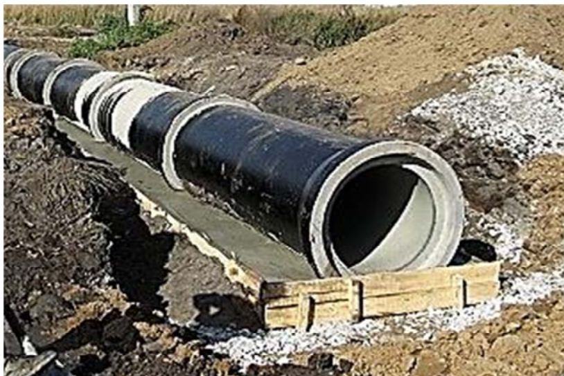
Рис. 4.1. Устройство водопропускной трубы
