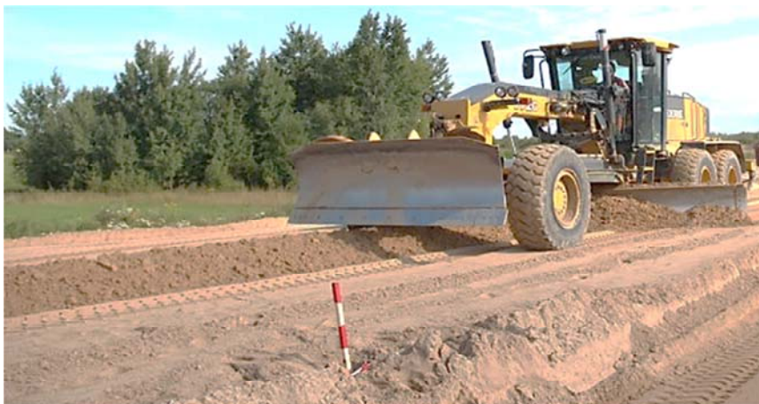
Рис. 5.24. Планировка верха земляного полотна
