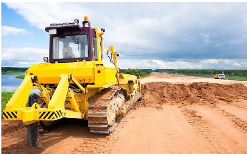
Рис. 5.6. Работа бульдозера на строительстве автомобильной дороги
