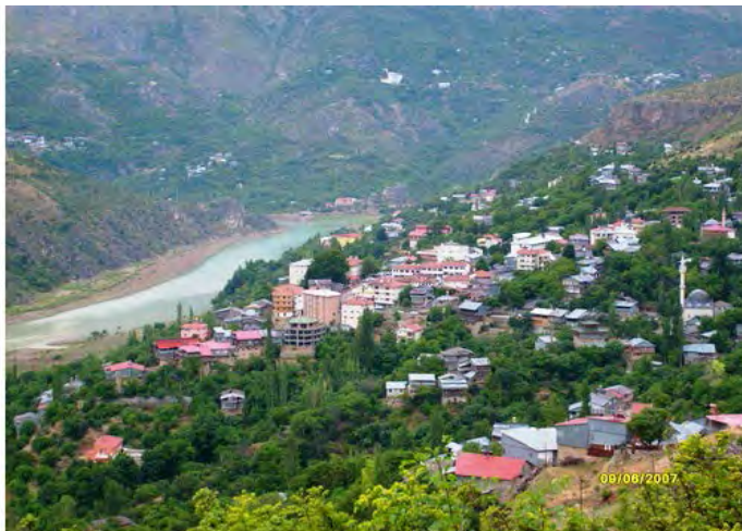
Рис. 1.4. Общий вид застройки поселка Кемалия на крутом (60 %) уклоне горного склона на отметке 980 м н.у.м.
