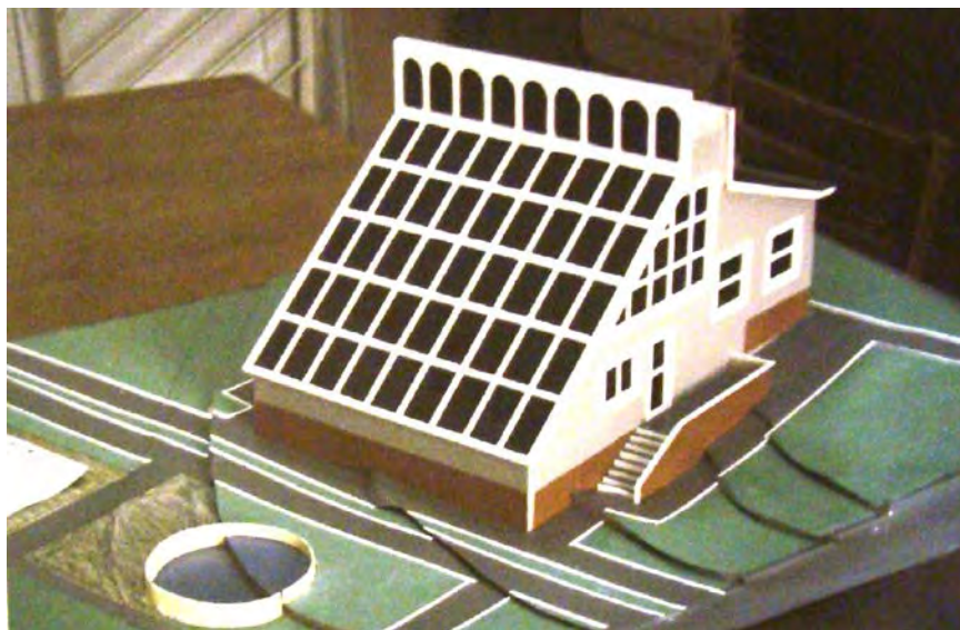
Рис. 3.13 Туристический приют на 40 мест с солнечной установкой автономного энергообеспечения для горных зон Заравшана и ГБАО. Макет экспериментального проекта. На крыше дома установлены солнечные коллекторы тепла и панели производители электроэнергии
