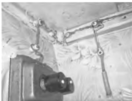
Рис. 1. Монтаж электропроводки открытым способом
