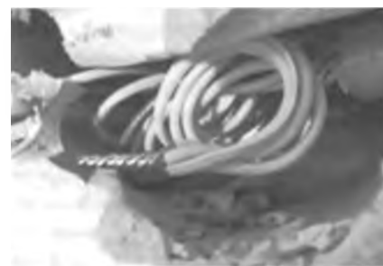
Рис. 3. Соединение проводов скруткой
