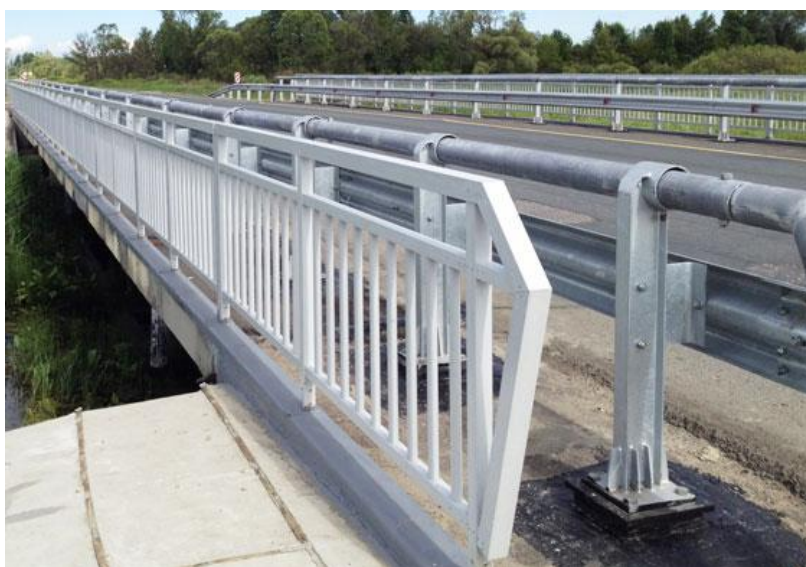
Рисунок 2 – Перильное ограждение из полимерного композиционного материала (трасса Москва - Волгоград)
