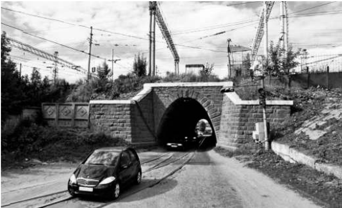
Рисунок 2 – Внешний вид тоннеля в насыпи железной дороги в створе Вишерской улицы в г. Перми
