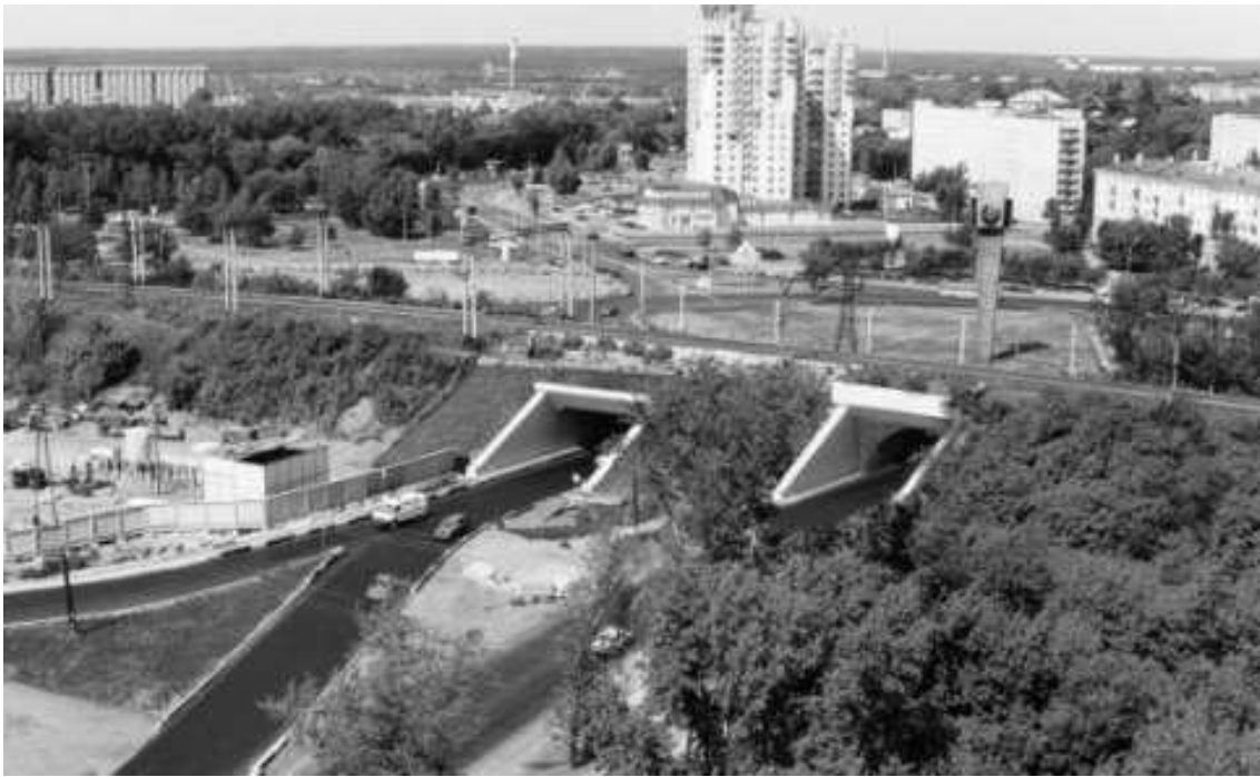
Рисунок 1 – Общий вид на старый (справа) и новый (слева) автотранспортные тоннели в створе улицы Локомотивной (площадь Гайдара) в г. Перми
