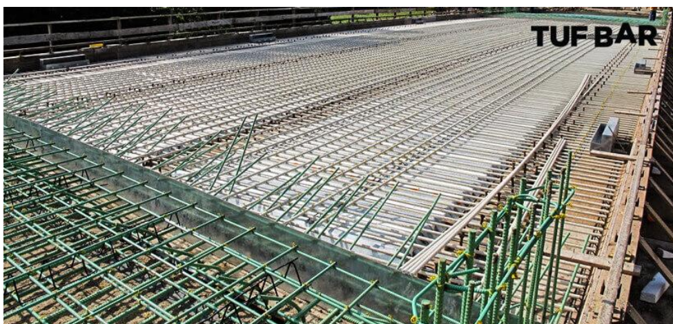
Рисунок 1 – Восстановление существующих мостовых сооружений
