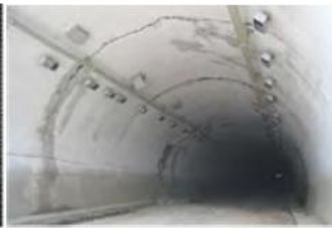
Рисунок 7 – Поперечные трещины
