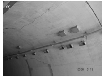
Рисунок 6 – Продольные трещины
