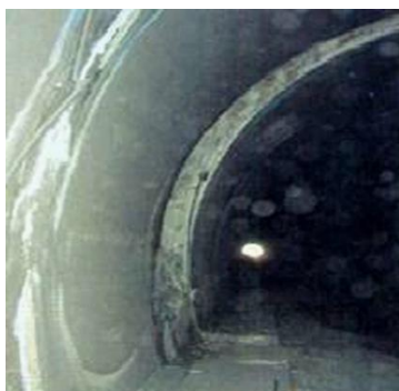
Рисунок 4 – Разрушение тоннеля при сдвиге грунта в зоне разлома
