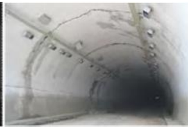
Рисунок 7 – Поперечные трещины
