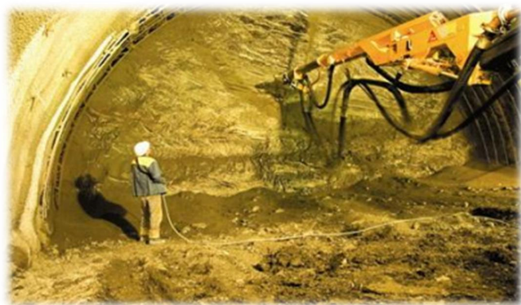
Рисунок 7 – самоходная машина для нанесения набрызг-бетона
