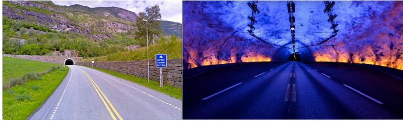
Рисунок 2 – Лердальский тоннель. Норвегия
