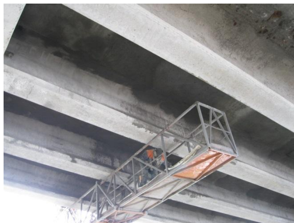
Рисунок 4 – Нанесение ремонтных бетонов методом торкретирования
