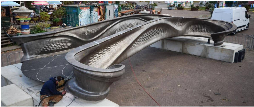
Рисунок 1 – Пешеходный стальной мост длиной 12 м, напечатанный на 3D-принтере компанией MX3D
