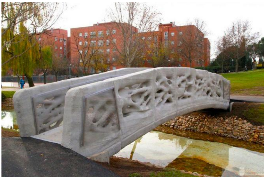
Рисунок 2 – Пешеходный мост в Испании длиной более 12 м и шириной 1,75 м, созданный с помощью 3D-принтера компанией Acciona
