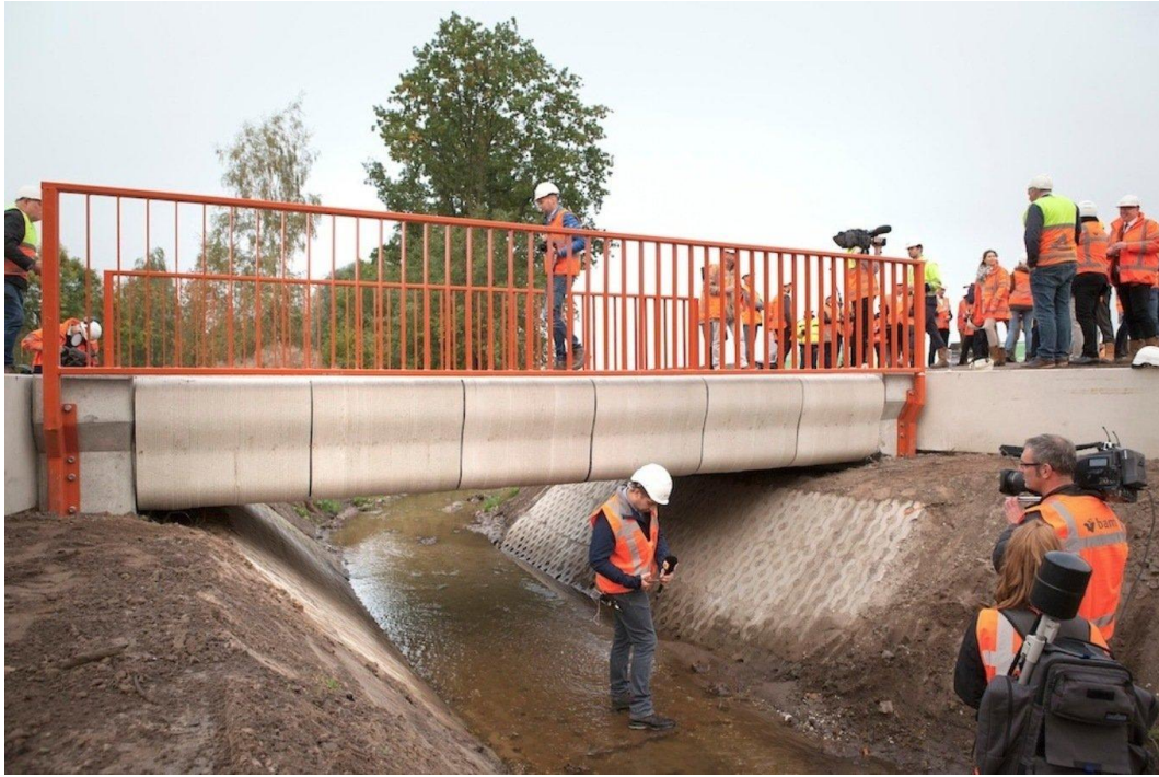
Рисунок 3 – Мост для велосипедистов длиной 8 м и шириной 3,5 м, напечатанный на 3D-принтере. Построен инженерами из Технического университета Эйндховена и строительной компанией BAM Infra
