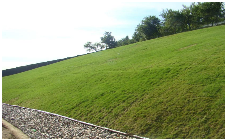
Рисунок 1 – Укрепление откоса насыпи травой
