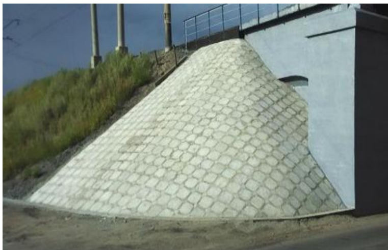
Рисунок 2 – Укрепление конуса насыпи бетонными плитами
