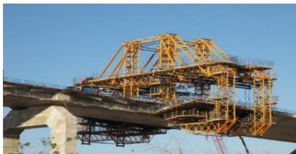
Рисунок 3 – Транспортировка готовой конструкции к месту установки
