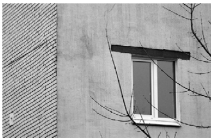
Рис. 7. Отделка оконных проёмов
