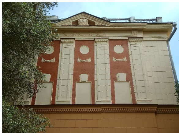
Рис. 6. Торцевой фасад здания по ул. Коммунистическая, № 3 после выполнения работ. Фото автора (2018 г.)
