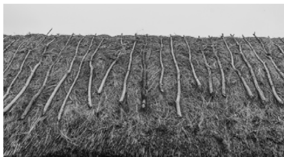
Рис. 6. Камышовая крыша, д. Кудричи, Пинского р-на. – фото автора
