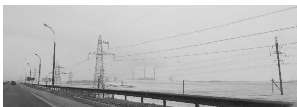
Рис. 11. ЛЭП вдоль МКАД. Фото автора
