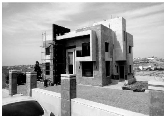
Рис. 6. Жилой дом. Шаркия. 2014 г. Арх. Бошар Мохсен
