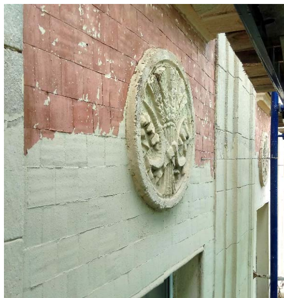
Рис. 4. Здание по ул. Коммунистической, 3. Расчистка декоративная керамическая плитки. Фото автора (2018 г.)
