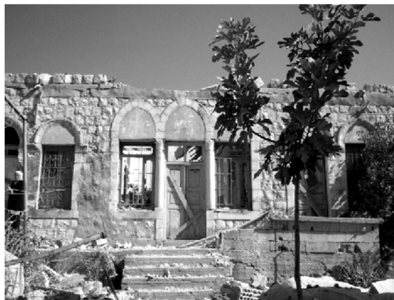
Рис. 1. Жилой дом. г. Бент Жбейль
