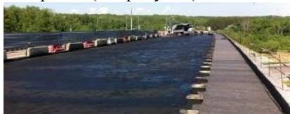
В этом случае конструкция проезжей части состоит из выравнивающего слоя, праймера, слоя гидроизоляционной мембраны и слоя асфальтобетона или литого асфальта.
