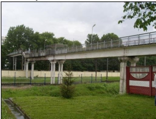
Общий вид сооружения до реконструкции
