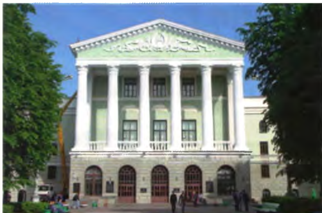
20. Главный корпус БПИ (БНТУ). Архит. Л. Рыминский, Л. Усова, Н. Маклецова. 1952 г.
