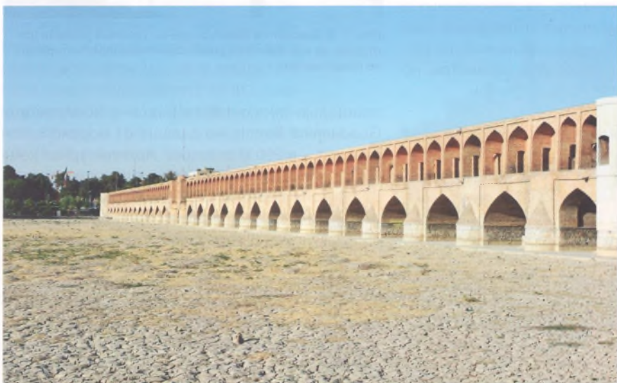
Рис. 11. Мост Си-о-СеПоль в Исфахане
