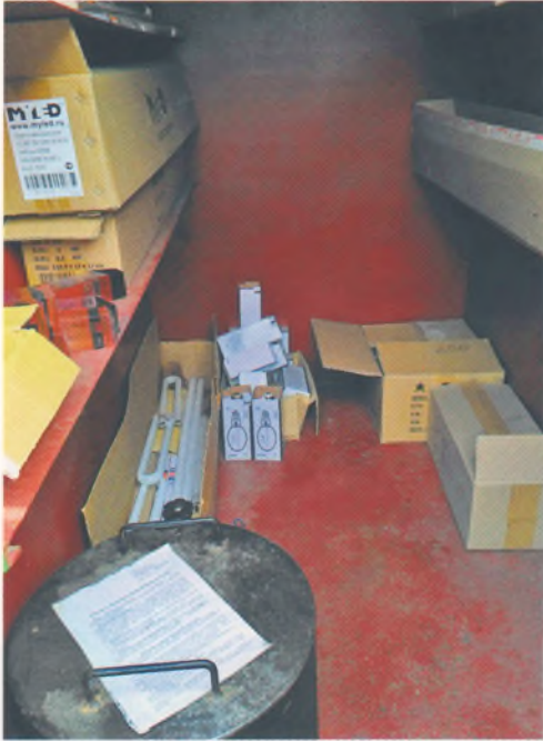
Поверхности склада покрыты ртутьнепроницаемой краской, в наличии Инструкция, средства для демеркуризации, лампы собираются по видам
