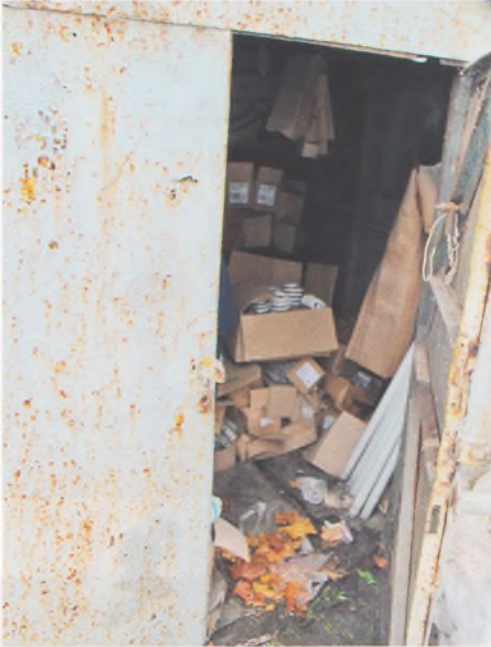
Ошибка. Помещение не промаркировано, в помещении не соблюдаются требования НПА и ТНПА к сбору ртутьсодержащих отходов
