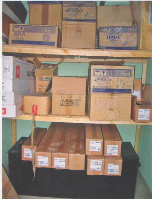
Ошибка. Сбор ламп организован хорошо, но деревянные стеллажи не покрыты ртутьнепроницаемым составом. Емкость для сбора боя не промаркирована и загромождена
