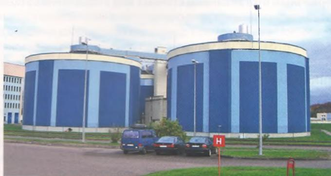
Рис. 6. Метантенки цилиндрической формы
