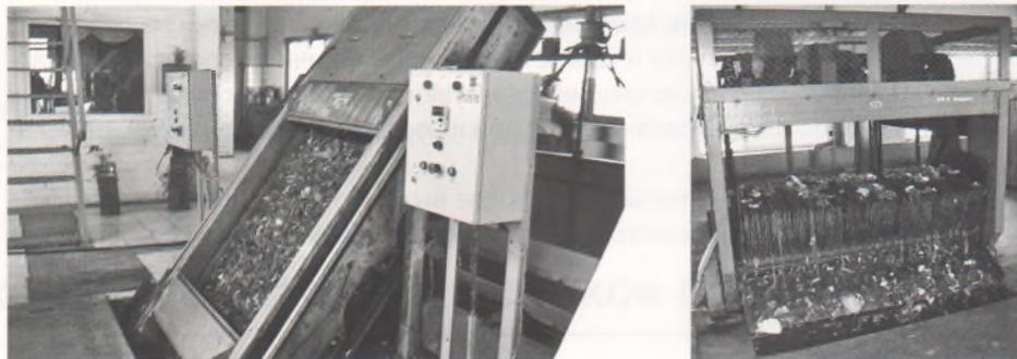
Рис. 2. Решетки для задержания крупноразмерных примесей
