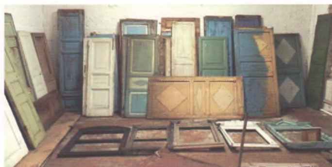
Рис. 5. Демонтированные старые двери
