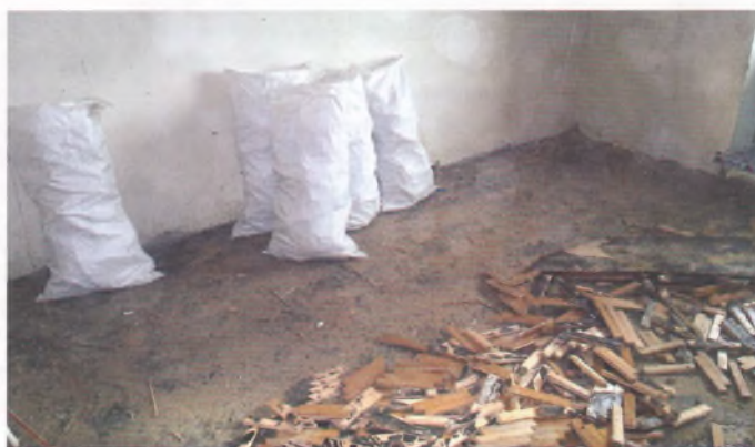
Рис. 3. Отходы после демонтажа пола
