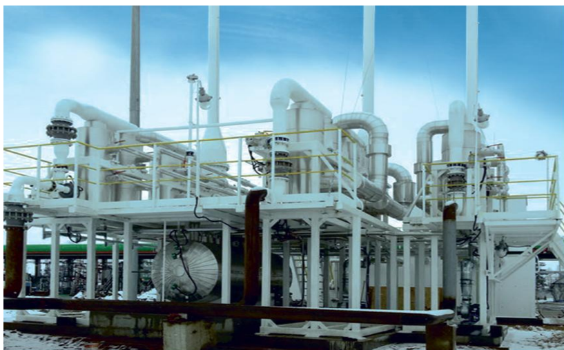
Рисунок 1. – Комплекс конденсации и рассеивания паров нефтепродуктов ККР-1200
