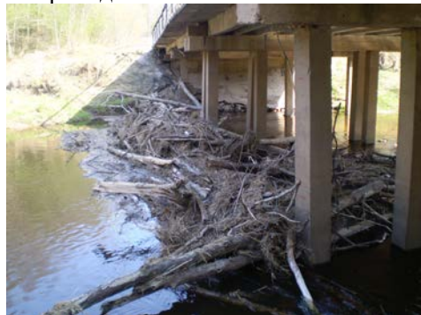
Рис. 3. Нагромождение плавника в русле р. Черница под мостом на автодороге Н-2906 Костеево – Бабиновичи, км 10,165 (май 2009 г.)
