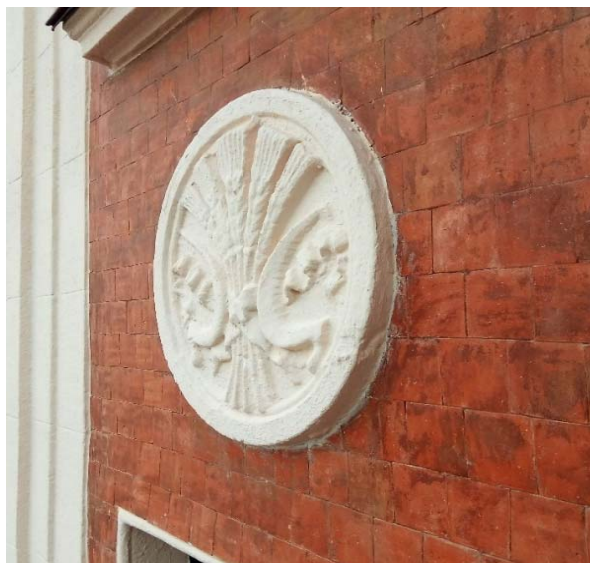
Рис. 5. Здание по ул. Коммунистической, 3. Декоративная керамическая плитки после расчистки. Фото автора (2018 г.)
