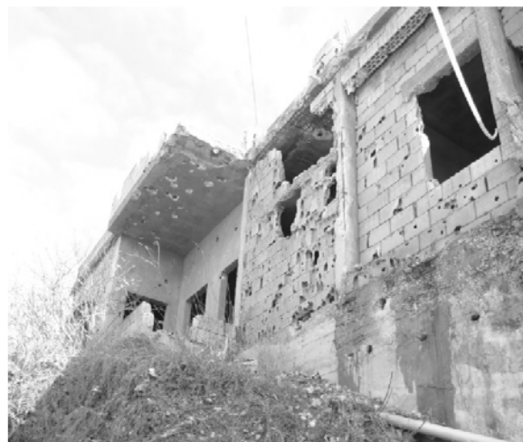
Рис. 1. Жилой дом в г. Айната
