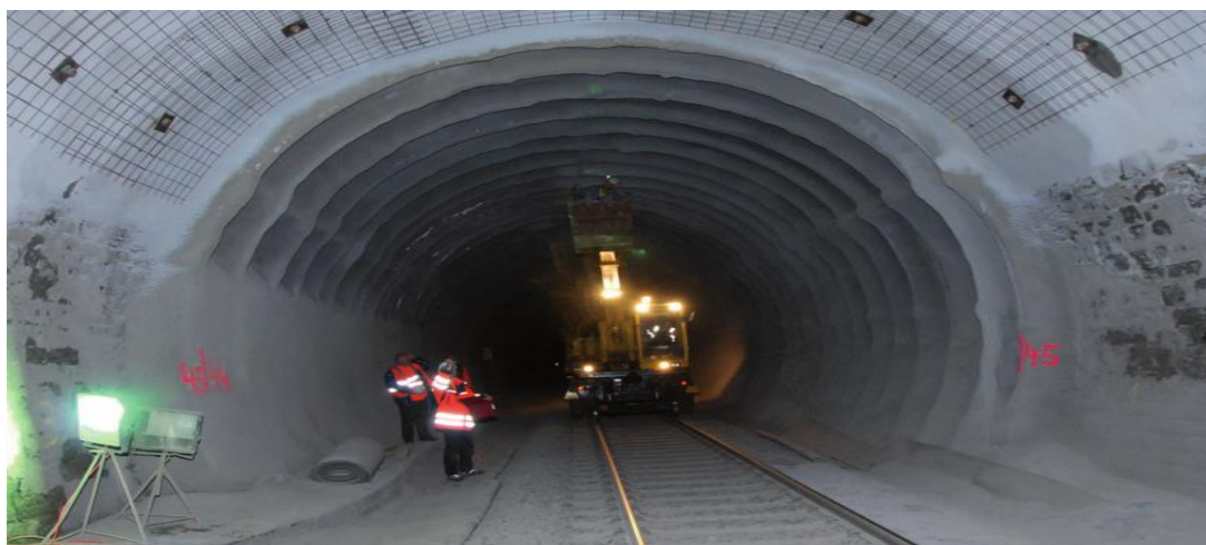
Рисунок 5 – Возведение тоннеля методом «ТИТАН»
