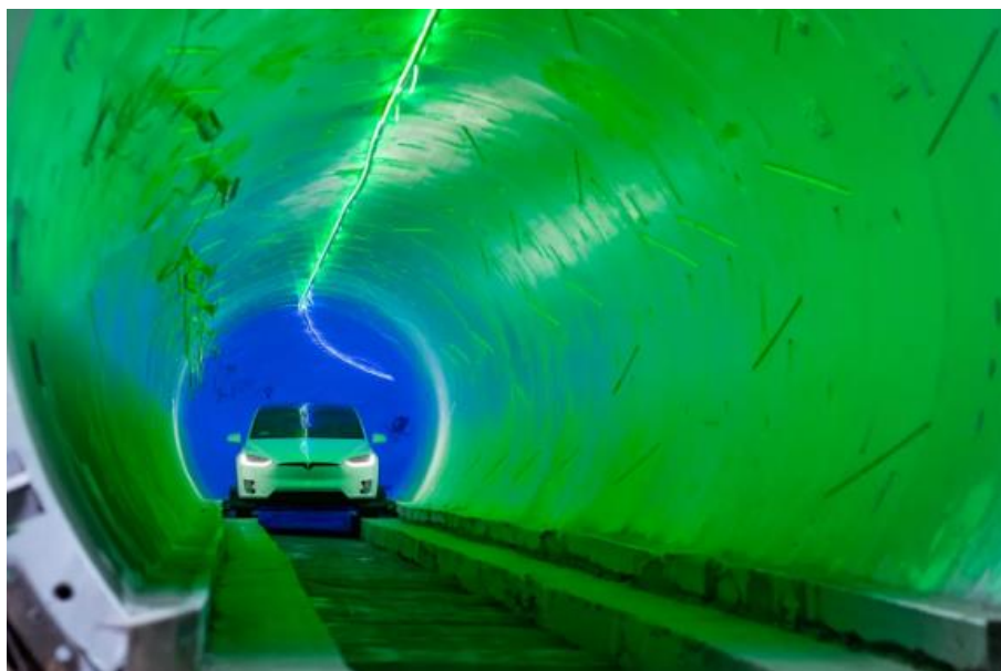
Рисунок 10 – Движение электрокара по тоннелю
