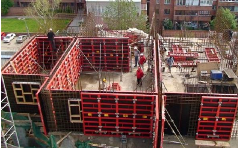
Рисунок 10 – Опалубка для заливки стен
