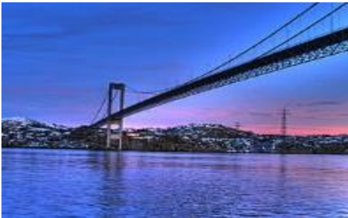
Рисунок 2 – Мост через морской пролив “Фьорды”
