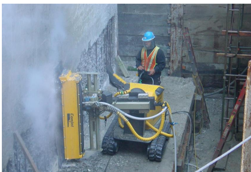
Рисунок 2- Применение технологии гидроразрушения при реконструкции тоннеля
