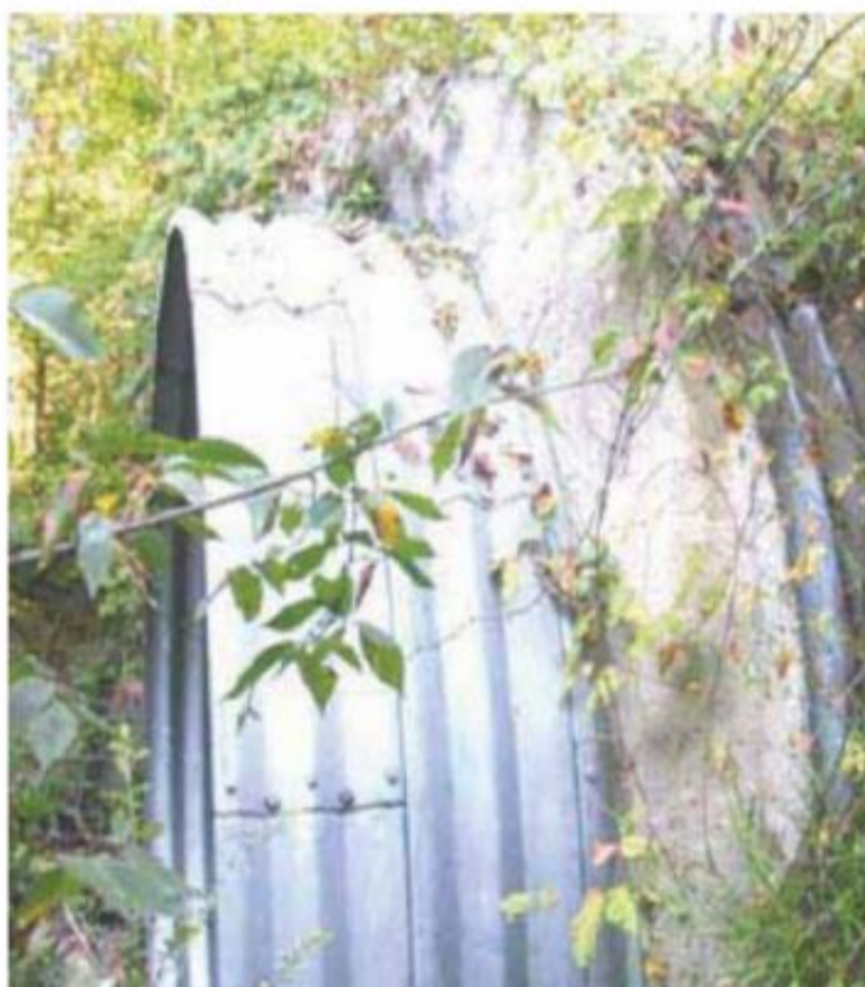
Рисунок 3 – Пример готовой усиленной водопропускной трубы
