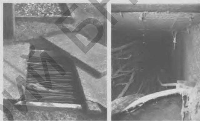
**Рис. 6.** Пример совместной прокладки силовых и контрольных кабелей (все кабели в кабельном лотке и канале расположены совместно без разделения на отдельные пучки)
