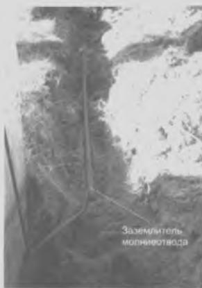
**Рис. 2.** Примеры неправильного исполнения заземлителей молниеводов (заземлители молниеводов не соответствуют требованиям по конфигурации и глубине прокладки)
