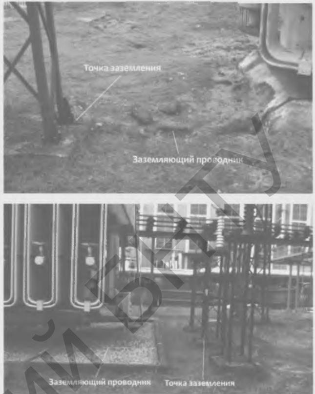
Рис. 1. Примеры неправильного заземления силовых трансформаторов (а — на ближайшую опору; б — на стойку с ОПН)
