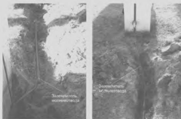
**Рис. 2.** Примеры неправильного исполнения заземлителей молниеотводов (заземлители молниеотводов не соответствуют требованиям по конфигурации и глубине прокладки)
