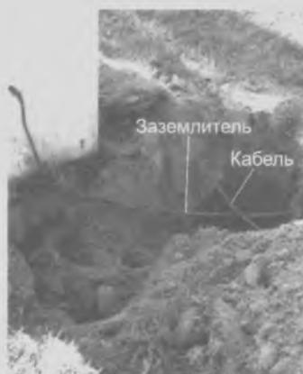
**Рис. 3.** Примеры несоблюдения допустимых расстояний от заземлителей молниеводов до кабелей вторичных цепей (заземлители молниеводов проложены в непосредственной близости от кабелей вторичных цепей)
