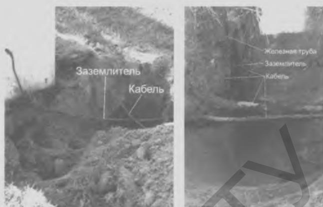
**Рис. 3.** Примеры несоблюдения допустимых расстояний от заземлителей молниеотводов до кабелей вторичных цепей (заземлители молниеотводов проложены в непосредственной близости от кабелей вторичных цепей)
