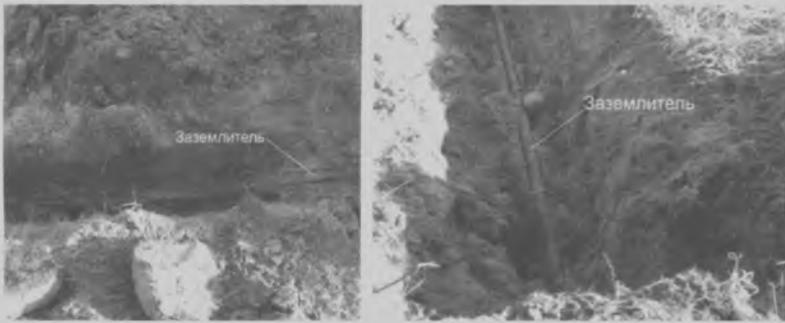
Рис. 8. Примеры прокладки заземлителей на малой глубине (заземлители проложены на глубине не более 0,2 м)
