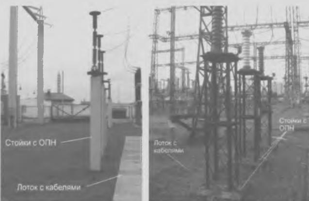
**Рис. 4.** Примеры несоблюдения допустимых расстояний от заземлителей ОПН и разрядников до кабелей вторичных цепей (устройства для ограничения перенапряжений и кабельные лотки расположены в непосредственной близости)
