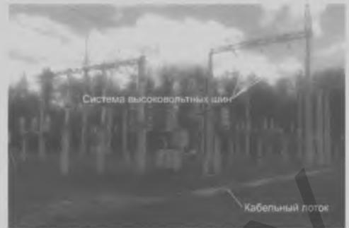
Рис. 9. Прокладка кабелей вторичных цепей вдоль высоковольтных шин
