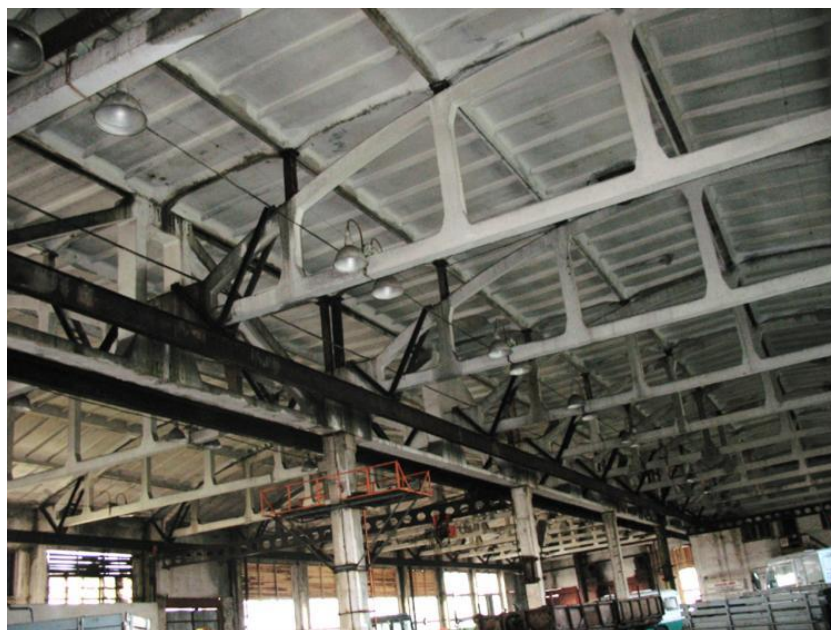
Рис. 1.41. Фото одноэтажного промышленного здания.
