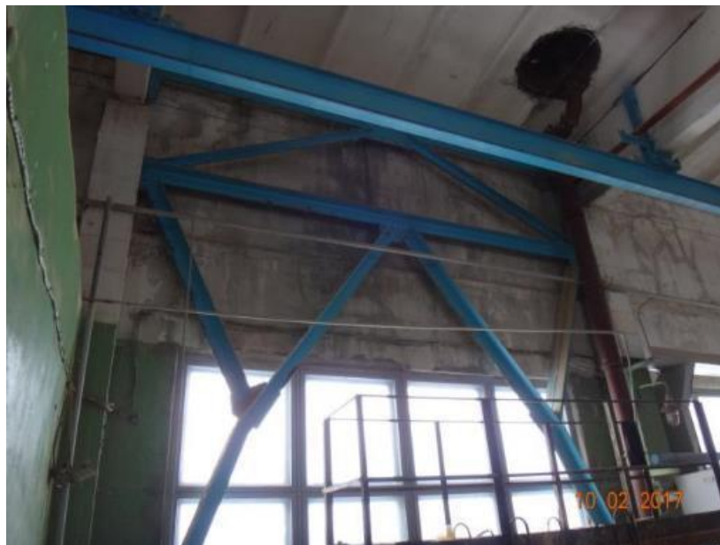
Рис. 1.42. Вертикальные стальные связи жесткости.
