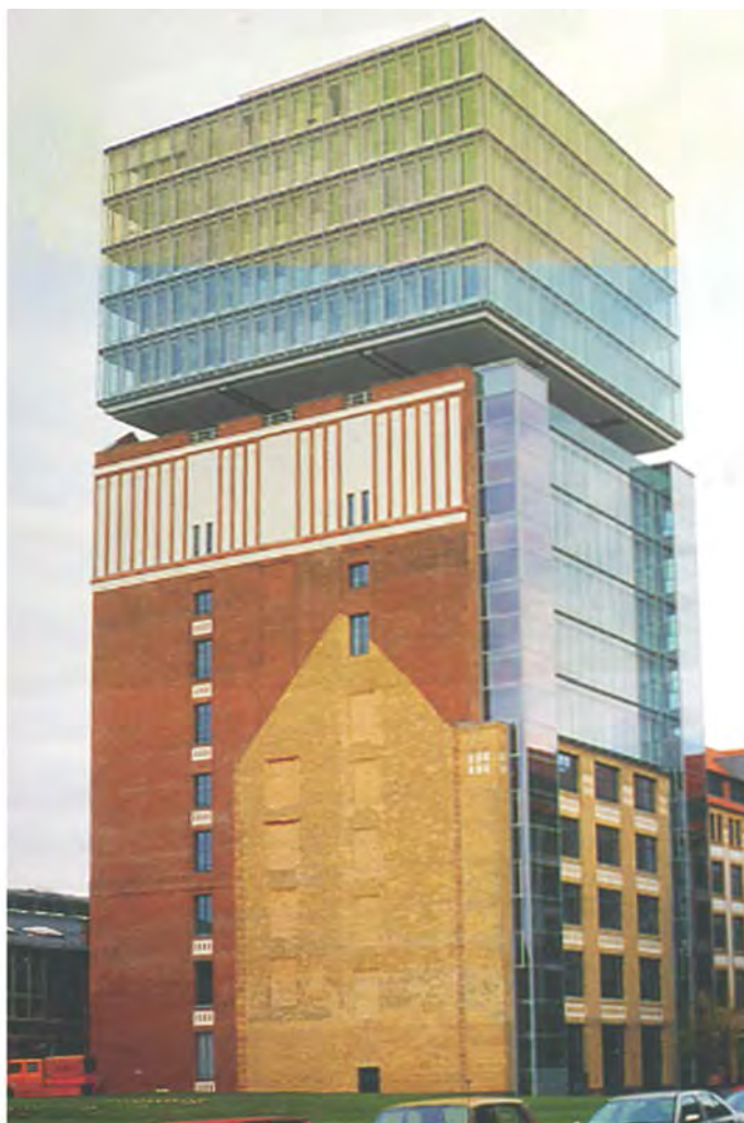
Рис. 6.11. Выявление в решении фасада производственного здания этапов реконструкции
