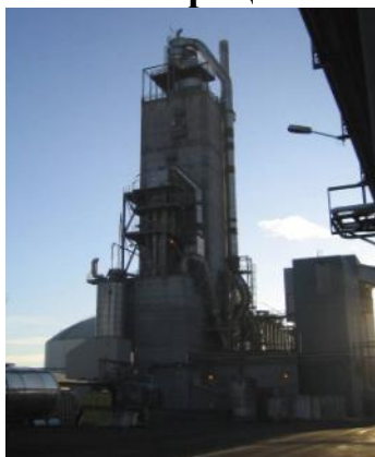
Производство доломитовой извести в печах циклонного типа.
