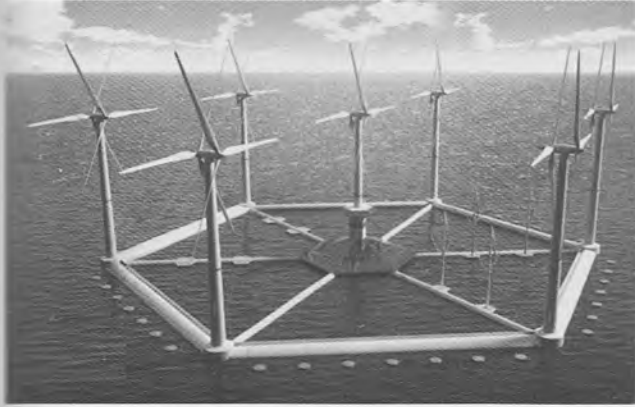
Рис. 3. Опытный образец плавучей платформы (Hexicon)
