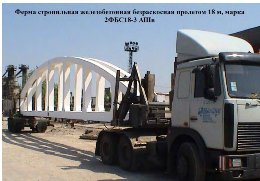
Рис. 1.3. Транспортировка безраскосных ферм
