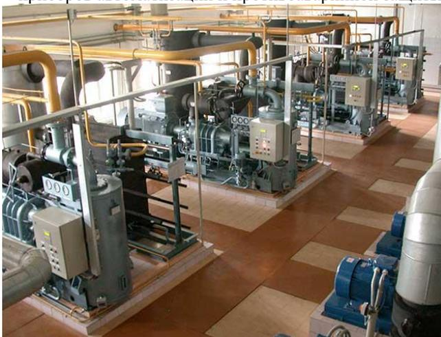
Рисунок1 :Помещение компрессорной аммиачной холодильной установки.
