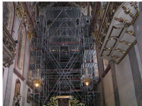
Рисунок 3 – Ремонтные работы в главном нефе Базилики
