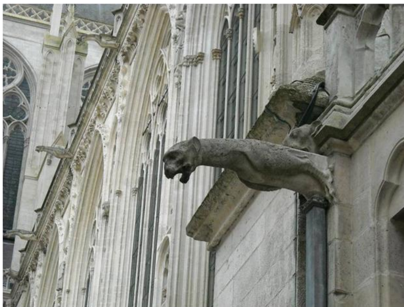
Рис. 14. Водосток в виде горгульи в соборе Амьена
