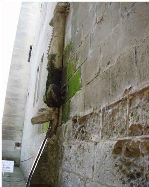
Рис. 15. Водосброс в виде ящера в замке Пьерфон
