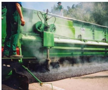
Рисунок 1.16 – Распределение литой смеси
