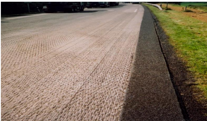
Рисунок 1.15 – Технологическая полоса, устраиваемая перед укладкой литой смеси
