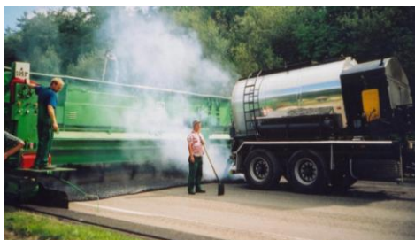
Рисунок 1.16 – Распределение литой смеси
