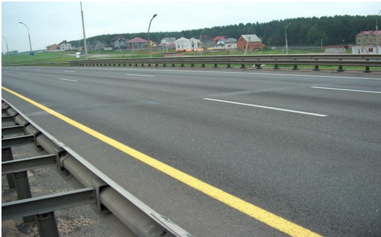
Рисунок 1.19 – Общий вид мостового полотна из полулитого асфальтобетона
