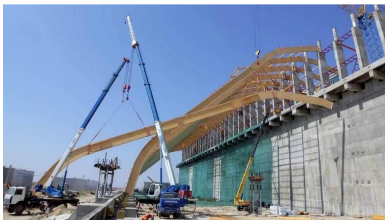
Рис. 2. Монтаж полуарок склада готового продукта Гремячинского ГОК
