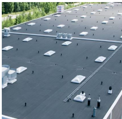
Рис. 5. Кровля с установленными флюгарками
