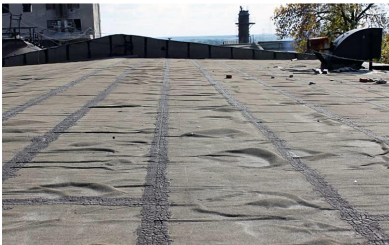
Рис. 1. Кровля с нижним слоем из перфорированного рубероида
