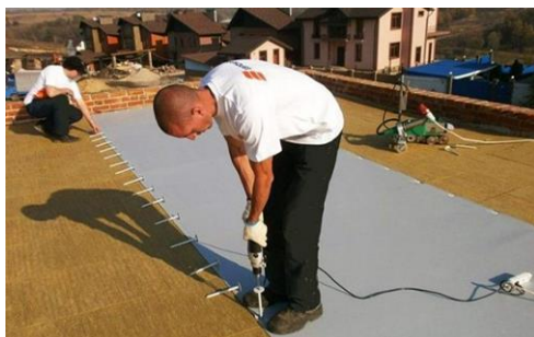
Рис. 4. Установка механического крепежа
