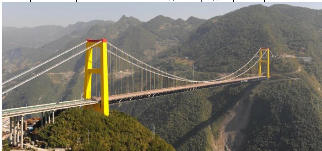
Иллюстрация 11.4. Висячий мост с фермой жесткости
