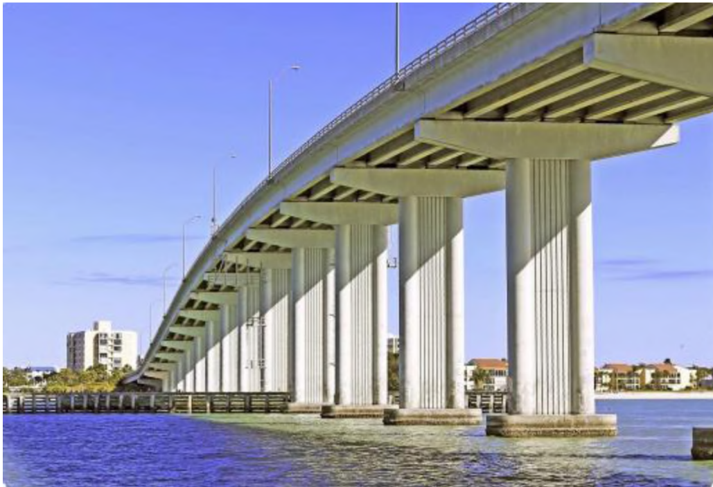
Иллюстрация 9.1. Нерезная балка
