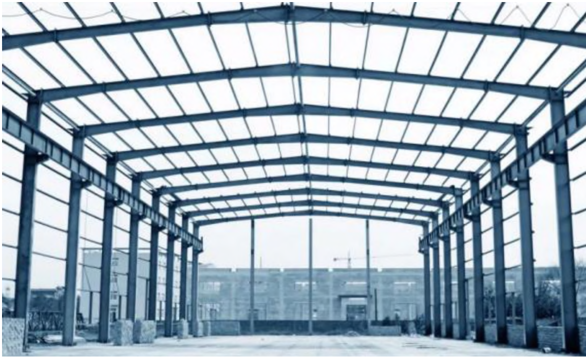
Иллюстрация 8.1. Поперечные рамы цеха
