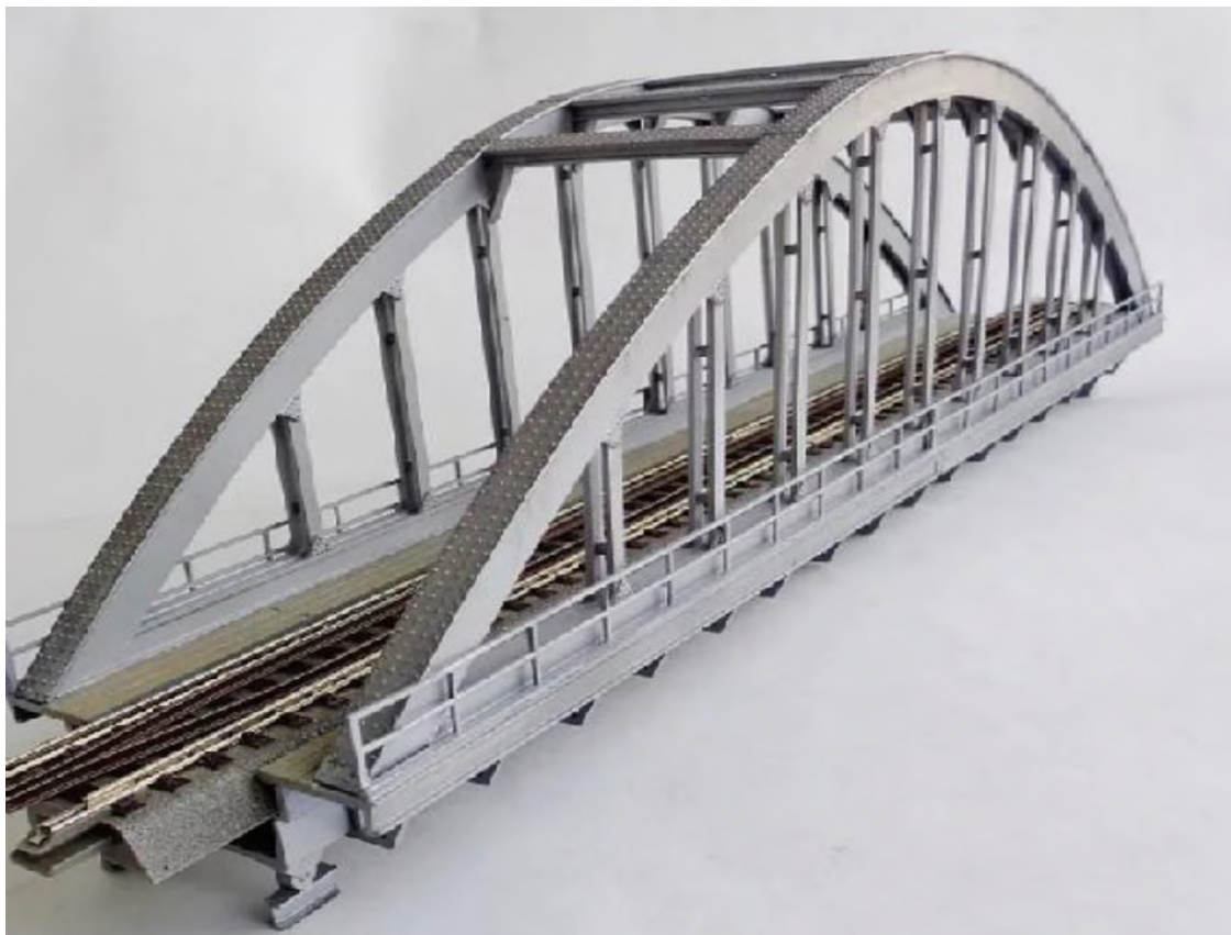
Иллюстрация 11.2. Двухшарнирная арка с затяжкой
