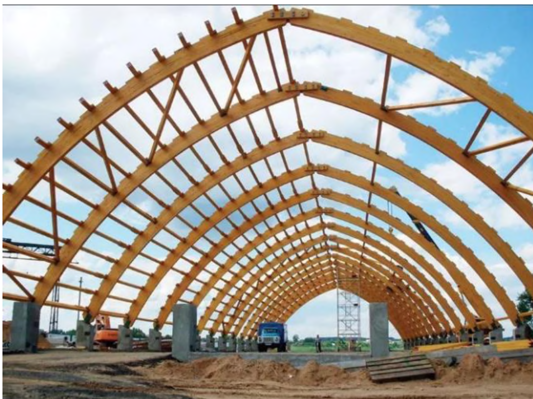
Иллюстрация 4.1. Строительство ангара из деревянных трехшарнирных арок
