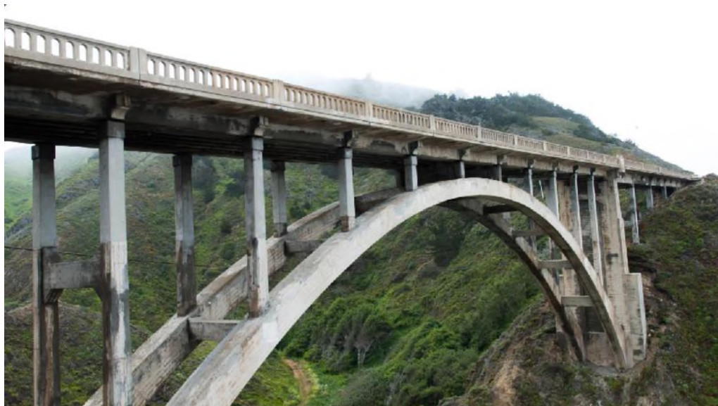
Иллюстрация 1.8. Распорная система в виде статически неопределимых арок с надарочным строением
