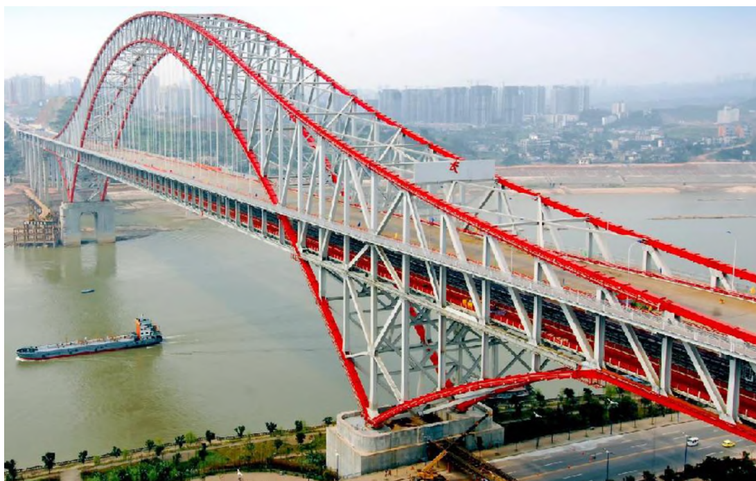
Иллюстрация 6.1. Арочные фермы моста с ездой посередине
