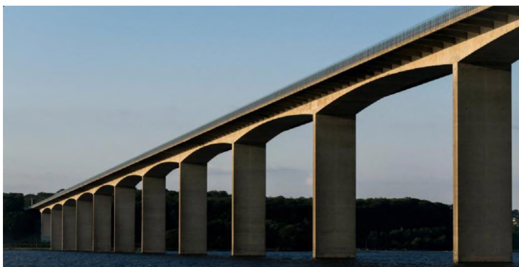
Иллюстрация 1.9. Безраспорная многопролетная статически неопределимая балка переменного сечения
