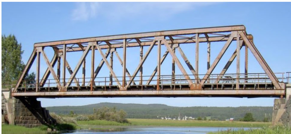
Иллюстрация 5.1. Балочные фермы однопролетного моста
