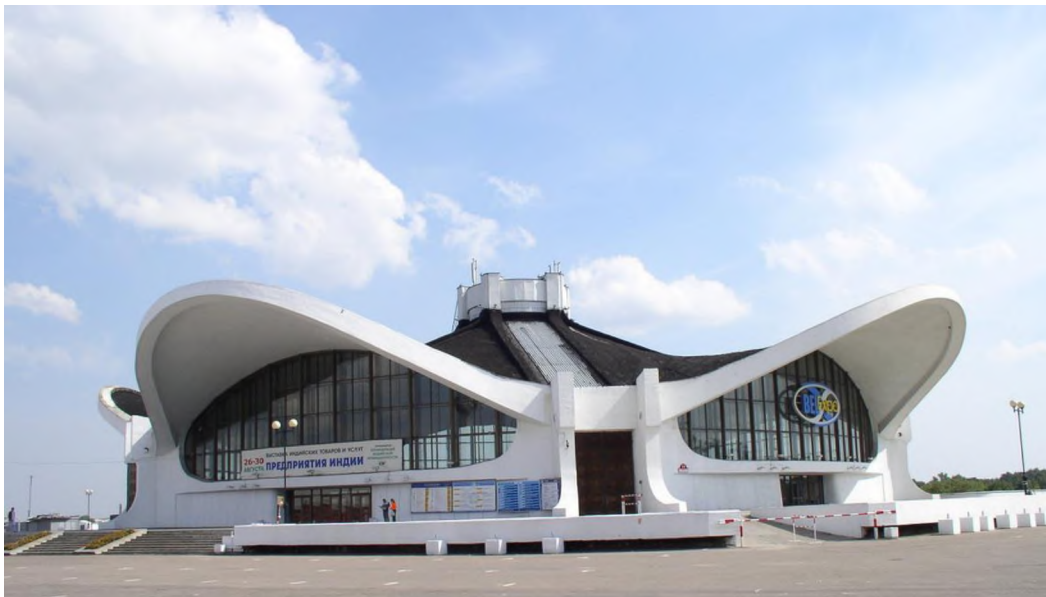
Иллюстрация 1.2. Висячая оболочка отрицательной гауссовой кривизны на арочном опорном кеонтуре
