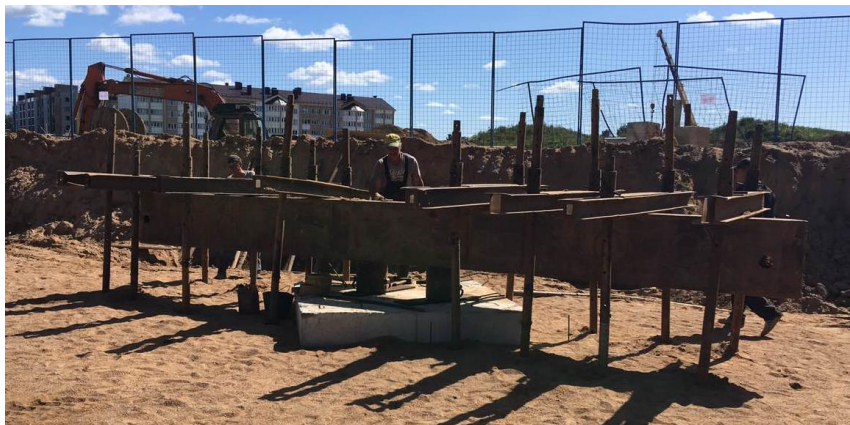
Рисунок 1. – Опытная установка на армированном грунте
