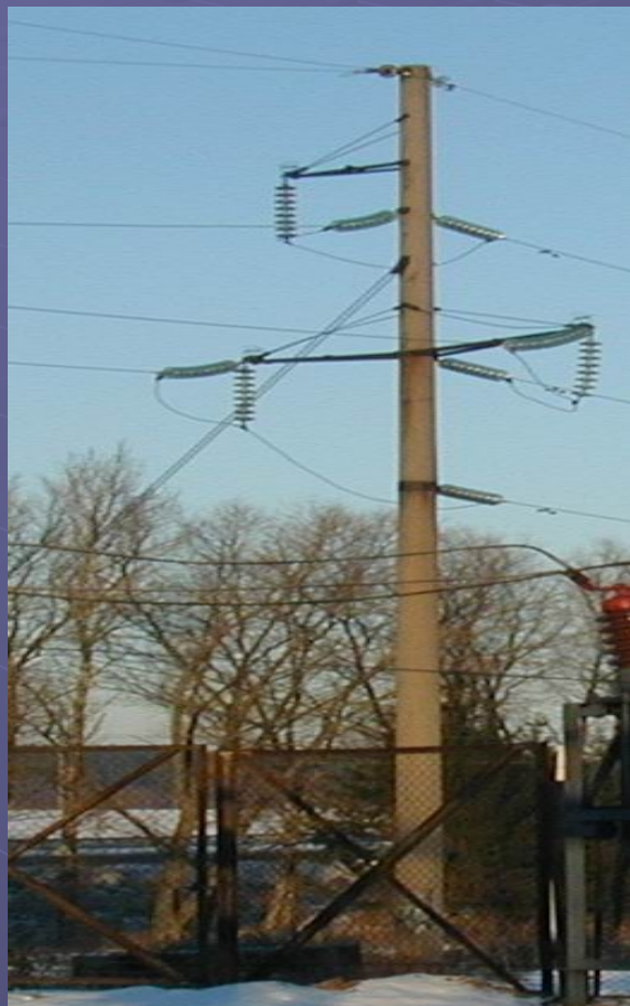
Железобетонная 110 кВ
