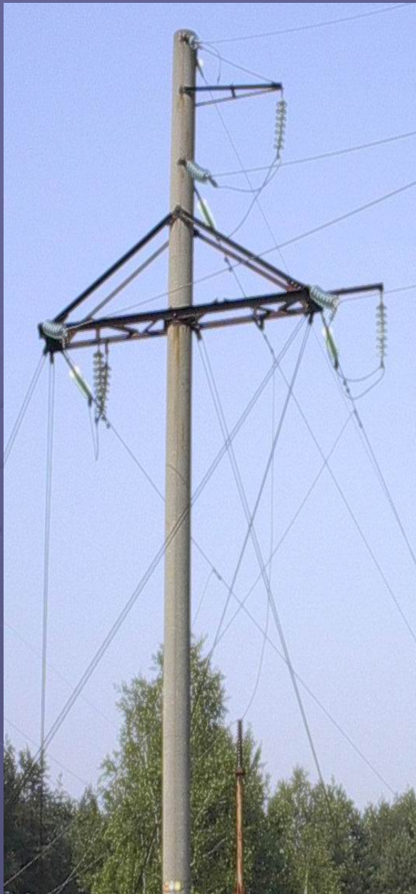
Железобетонная опора 110 кВ с оттяжками
