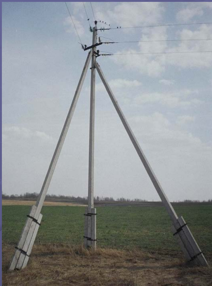
Железобетонная 10 кВ
