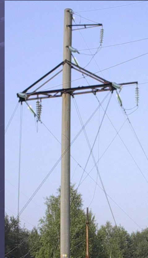
Железобетонная 110 кВ
